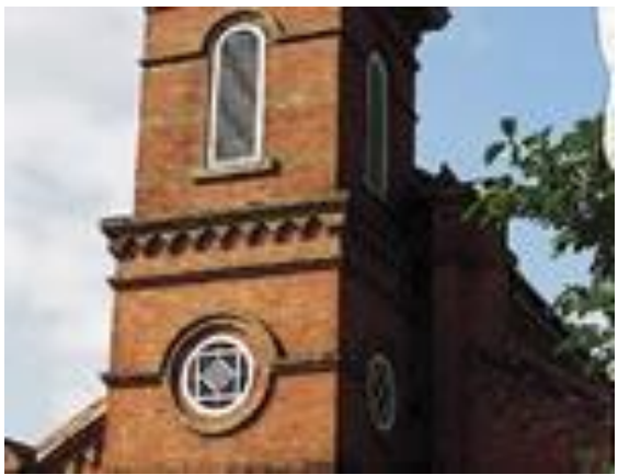
大曾教会【レンガ造】 大正時代には、レンガ造りの教会が多く創建された。レンガの積み工法には、イギリス積み、アメリカ積み、フランス積みがありそれぞれ違った表情をみせている。
