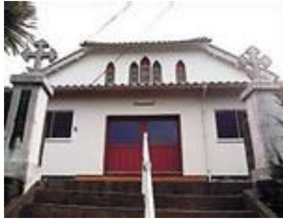
江袋教会【木造】 1882年に創建され、使用されている木造教会では県内最古の教会。
