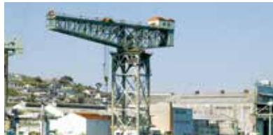
1909年、造船所の工場設備電化に伴い日本で初めて建設されたイギリス製の電動クレーン。
