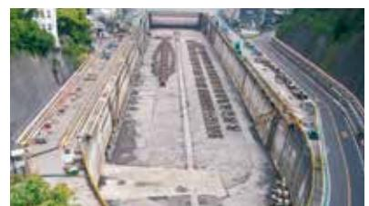
1905年に建設された大型船の修理施設(ドック)。船の大型化にともなって3度拡張された。
